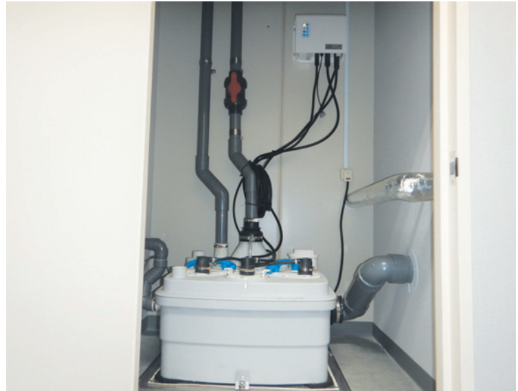
ポンプ設置状況
