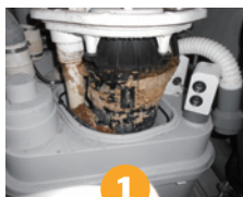
1 ポンプアッセンブリの清掃
