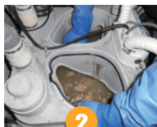
2 ユニット内部清掃
